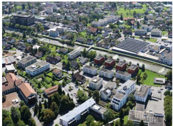
Wohnbaustrukturen entlang der Dornbirner Ach Quelle: Flugaufnahmen Dornbirn, 2014
