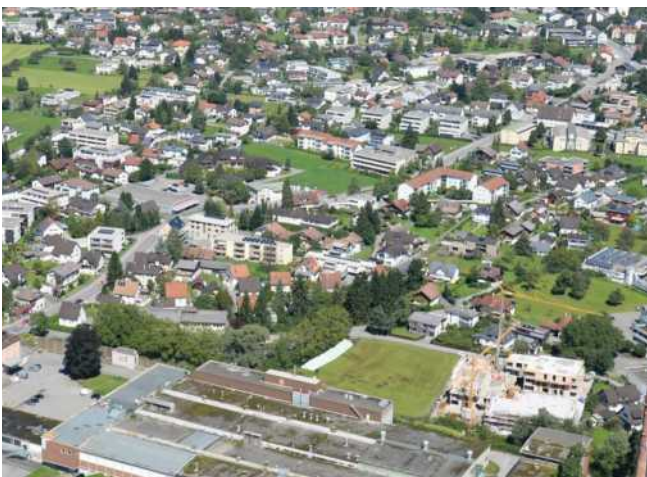
Baulandreserven Quelle: Flugaufnahmen Dornbirn, 2014
