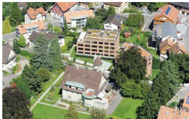
Geschoßwohnbau Oberdorferstraße Quelle: Flugaufnahmen Dornbirn, 2014
