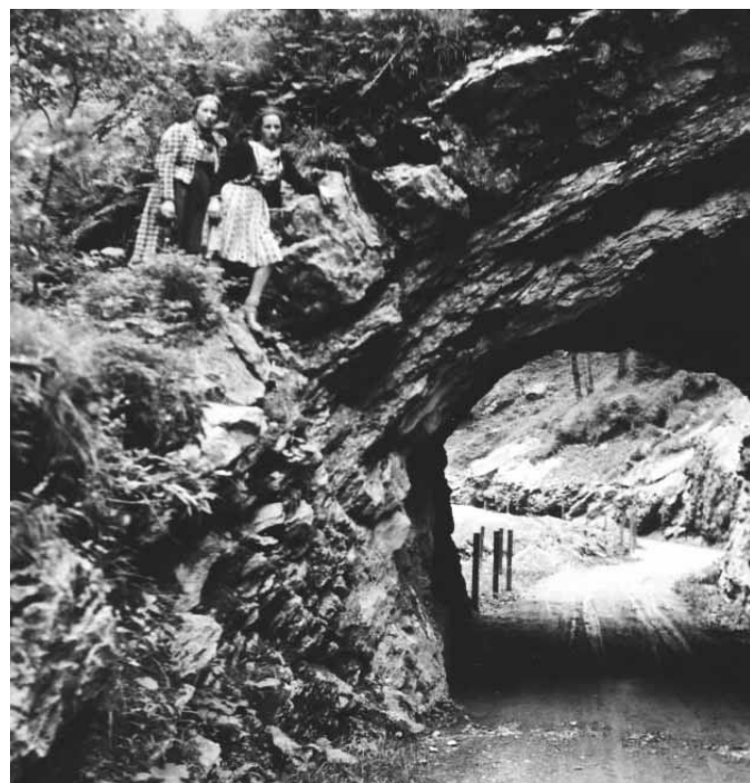
Tunnel bei der alten Bödelestraße
