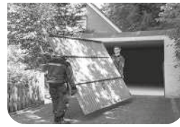
Ausbau und umweltgerechte Ent- sorgung
